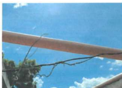
Foto 5: CANALES Y BAJADAS DE AGUA PLUVIAL Sustitución de canales para evacuación de aguas pluviales Material: lamina galvanizada Tipo: Ilsa, Anclaje: canal sostenido por pescantes metalicos
