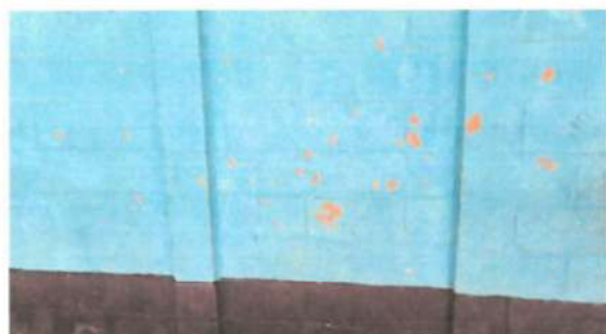
Foto 3: PINTURA EN MUROS INTERIOR Y EXTERIOR Preparación de la superficie y aplicación de pintura a dos manos, en paredes interiores y exteriores del establecimiento.
