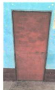
Foto 2: PUERTAS Suministro e instalación de puerta metálica, incluyendo chapa, bisagras.
