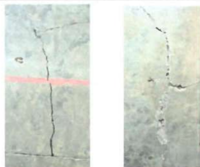
Foto 4: PISO Sustitución de piso de concreto con acabado liso por piso de granito, incluyendo preparación de superficie y nivelación.
